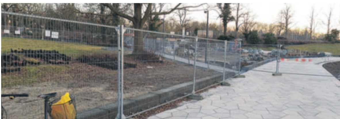
Der endlich sanierte Anleger am Wannsee soll mit einer angemessenen Feier wiedereröffnet werden. Foto: O. Schmidt
