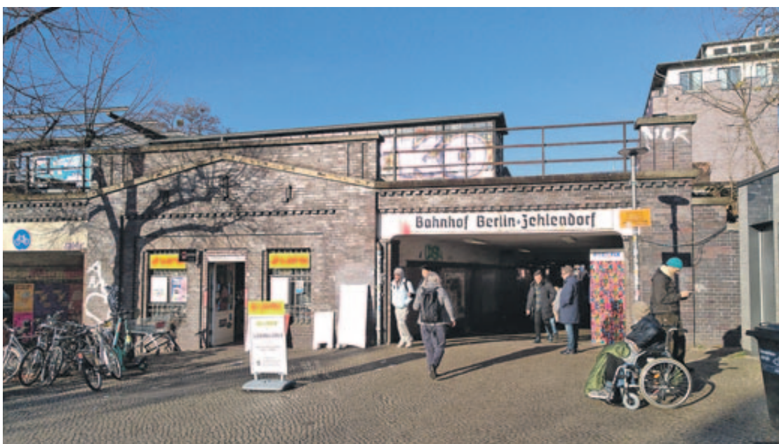
Provisorium – Die dringende Sanierung des Bahnhofs könnte sich weiter verzögern. Fotos: M.A. Schmidt
