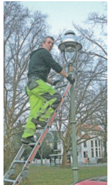
Besonders Gaslaternen im Bezirk sind störungsanfällig und schaffen Sicherheitslücken. Foto: M. A. Schmidt
