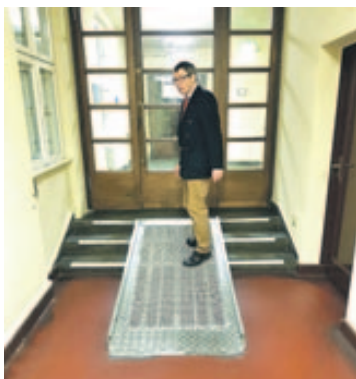
Für Rollstuhlfahrer zu steil: Die Rampe im Rathaus soll verlängert werden. Foto: R. Fröhlich
